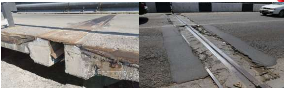
1-rasm. Deformatsiya choklarga maxsus kimyoviy moddalar ta'siri.
